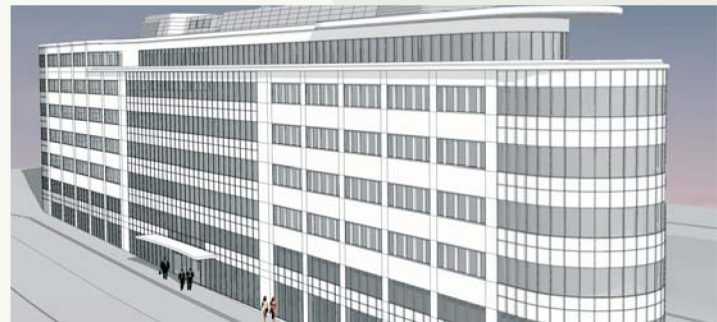
Genom att exponera elementfogarna på byggnaden istället för att försöka dölja dem gav man byggnaden ett intressant och modernt utseende.
